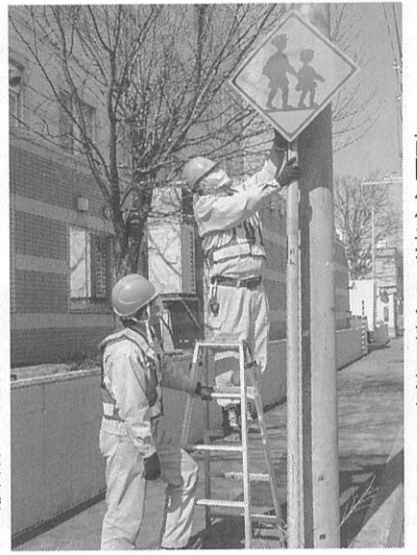
西園小付近での作業の様子
